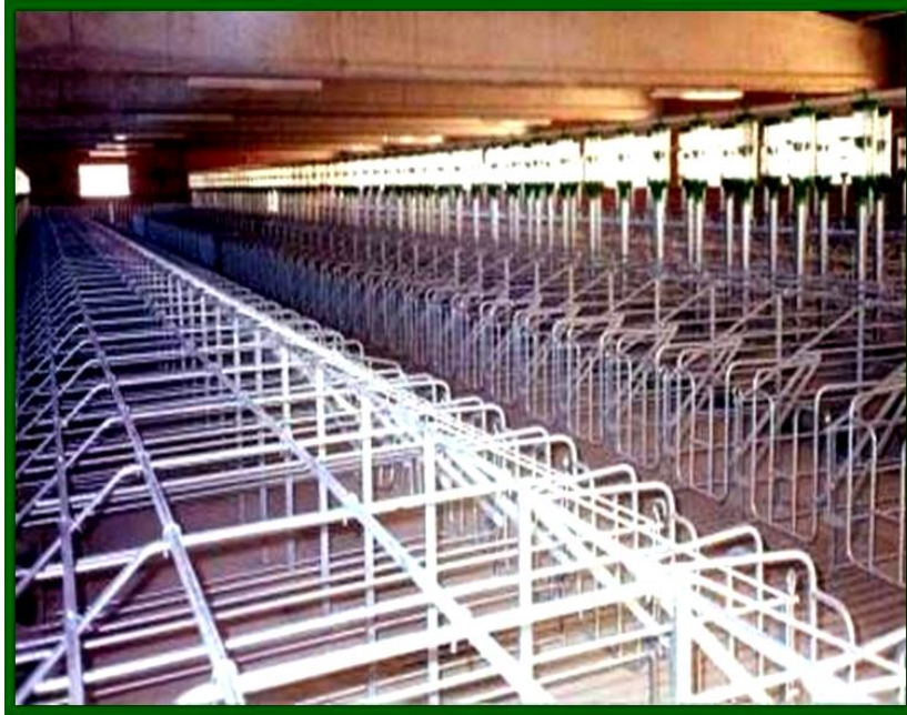
Foto 8.- Naves de gestación
